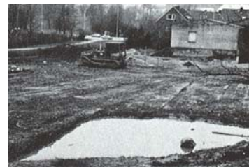
Der Mutterboden wurde abgeschoben (21. März 1981)
